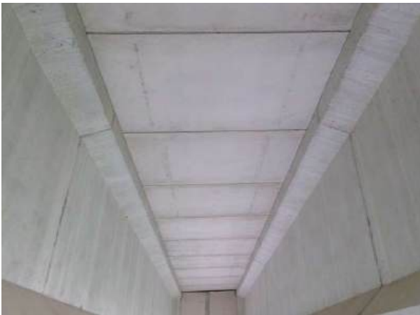
거더 및 바닥판하면 전경
