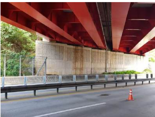
교대 A1 전경
